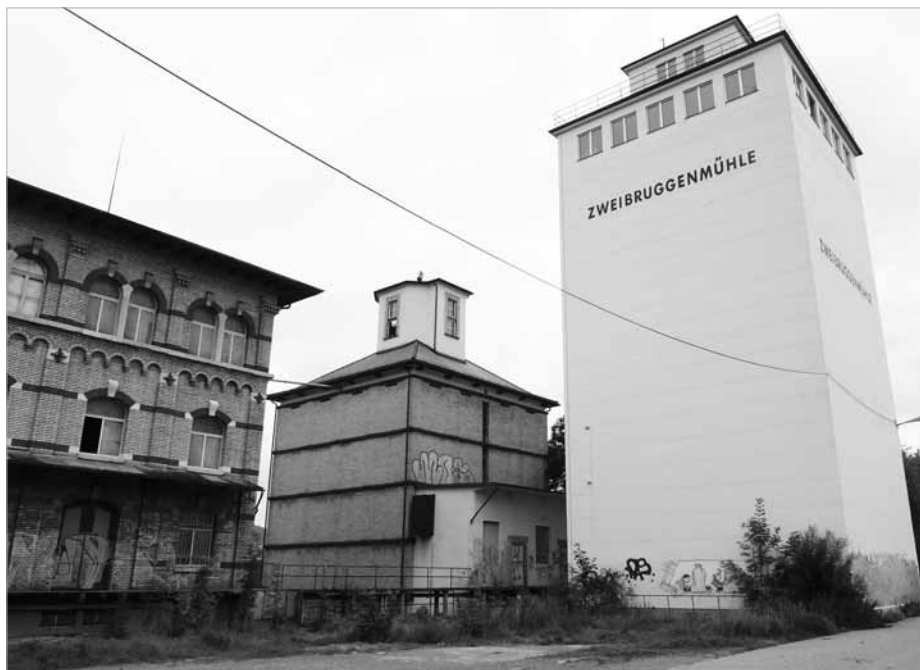
Am mittleren Gebäude nisteten die Mauersegler seit vielen Jahren. Es wurde – wie der hohe Turm rechts – abgerissen
